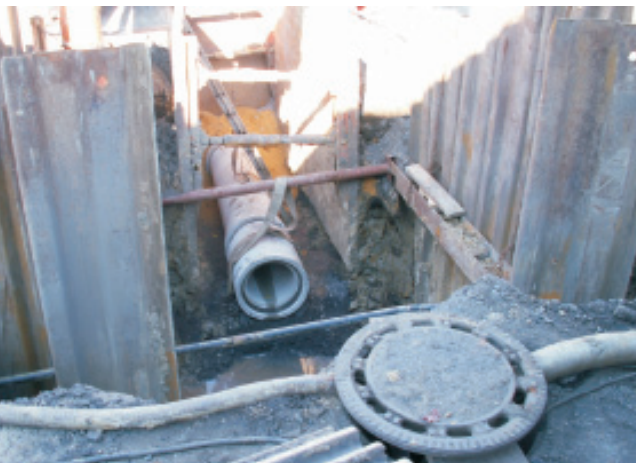
Schächte an der Grundstücksgrenze
